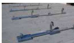
3. Profilstützen verschrauben
